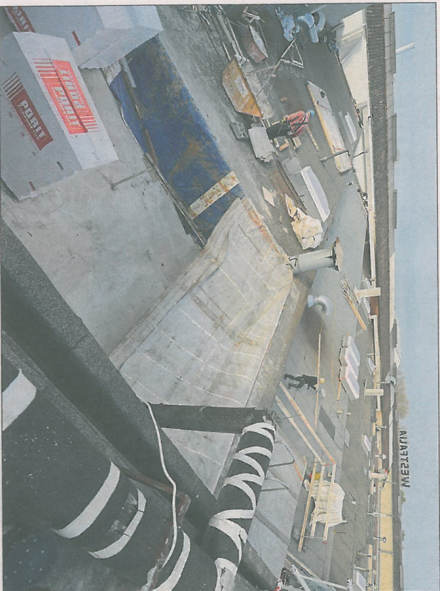
Bei Westfalia laufen die Geschäfte gut. Nun will das Unternehmen seine Produktion erweitern. Dafür werden derzeit das noch aus Vorkriegszeiten stammende Dach erneuert. Foto: Borgmeier
