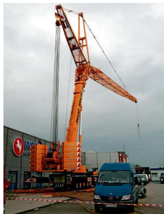
Bis zu 100 Meter hoch: Der Kran soll Stahlbetonträger über das vordere Gebäude heben.
