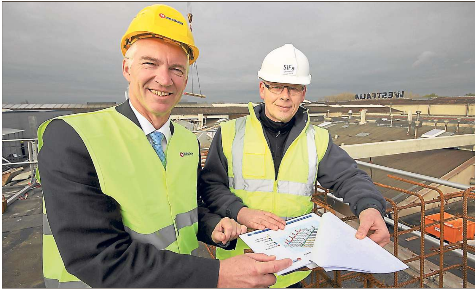
In luftiger Höhe überzeugten sich am Freitag Geschäftsführer Dr. Bernd Welzel (l.) und Andreas Mersch, Fachkraft für Arbeitssicherheit bei Westfalia Automotive, über den Fortschritt der Dacharbeiten am Stammsitz des Anhängerkupplung-Herstellers in Wiedenbrück. Bild: Grujic
